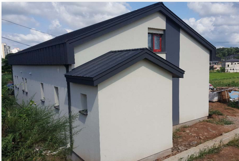
ZINC (리얼징크) 시공
