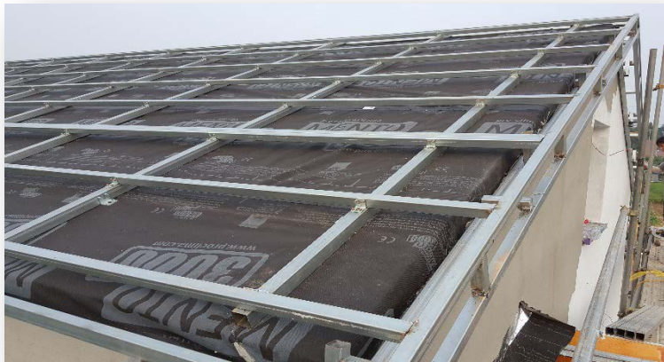
측면 처마 후레싱 부분 아연도 각파이프 (합판용) 설치 (용접)
