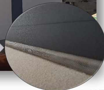
치마 VENT 방출열 설치
