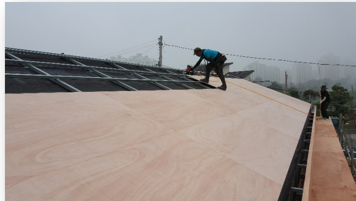
합판 설치 (zinc 바탈용)- 스크류타카 조립
