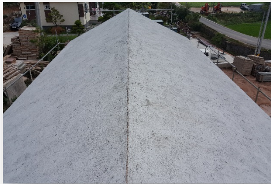
콘크리트 경사지붕 구조물 전경
