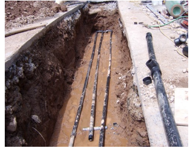
[지중 매립배관 설치]
