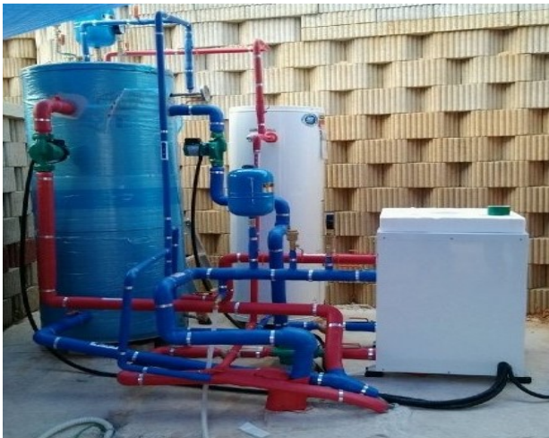
[지열 장비류 설치, 배관]
