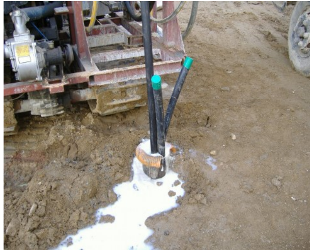
[지중 열교환기 설치]
